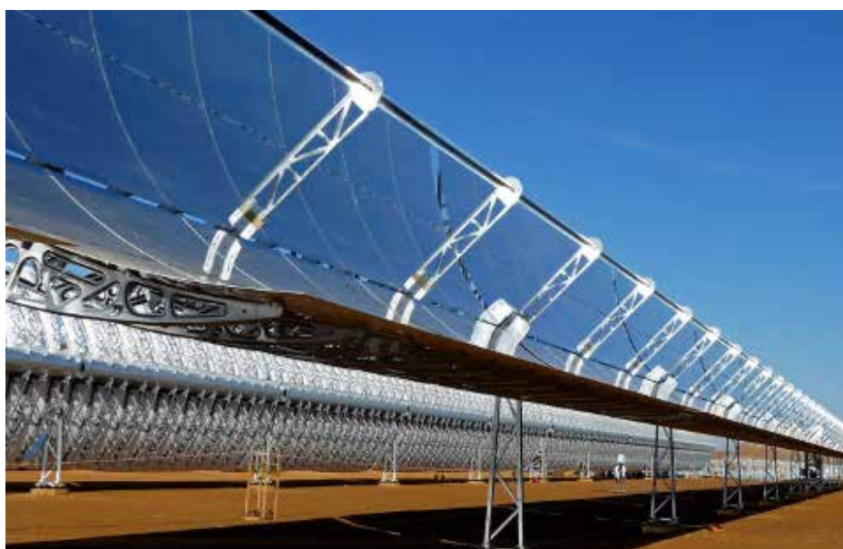
Figura 3.5 Colectores solares parabólicos para precalentado de electrolito de alto contenido en cobre.
