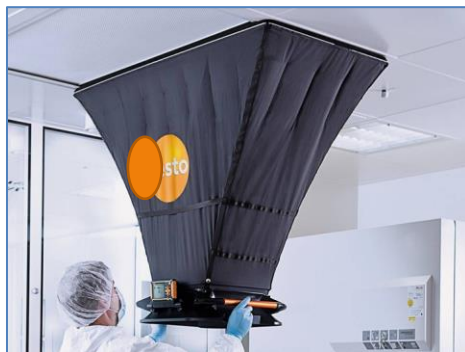
4142 4143 Figura 10.8.8: Ejemplo del uso de campana de medición de caudal de aire
