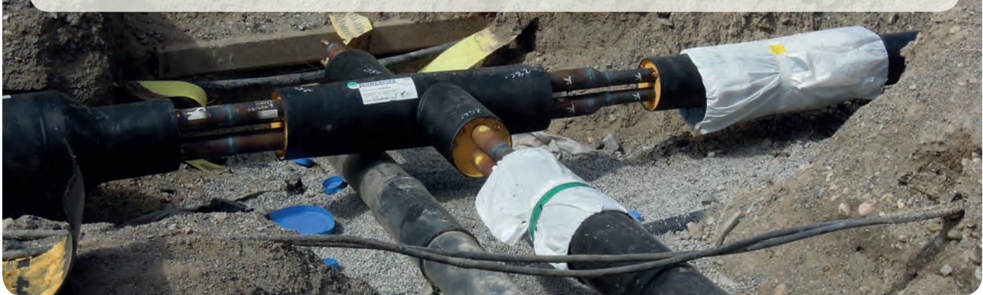
Figura 1-2 Vista de las tuberías que componen el sistema de distribución para una red de Energía Distrital. Autor: Dependability, bajo licencia CC BY-SA4.0
